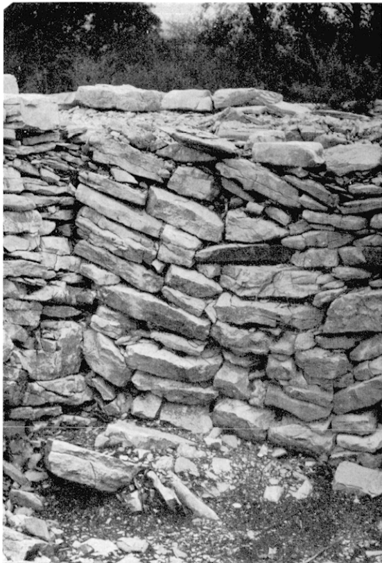
23 Saint-Martin-de-Londres. Village chalcolithique de Conquette. Mur du fond de la maison V, encore conservé sur 1,10 m de hauteur.
