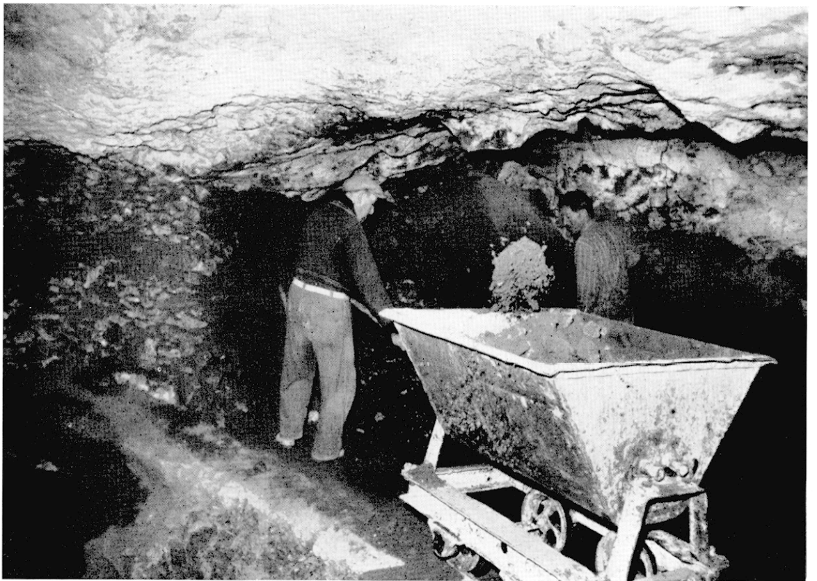
Fig. 13. — Vers (Gard). Grotte de la Balauzière. En haut, l'entrée de la grotte et l'échafaudage pour l'évacuation des déblais. En bas, l'évacuation des déblais de l'Abbé Bayol ( Cliché H. de Lumley ).
